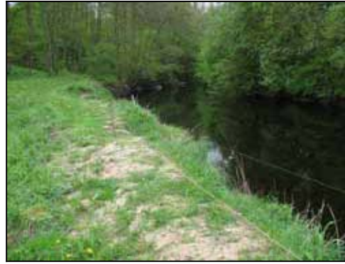
Bild 4. Levé med nyligen pålagrad sand, sträcka I
