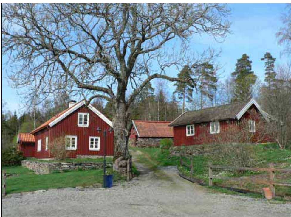
Det äldre boningshuset till vänster, källare och uthus till höger.
