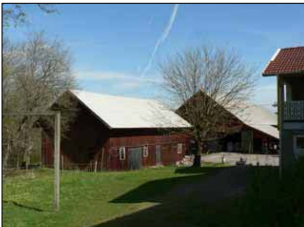
Boden med logen skymtande bakom.
