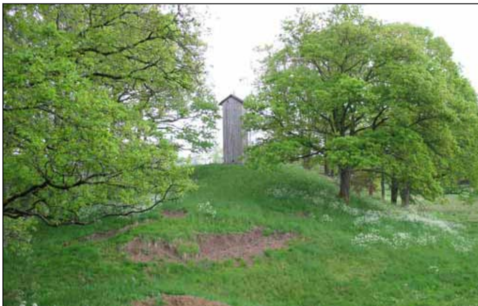
Transformatorstation i hagmarkerna nära Storån.
