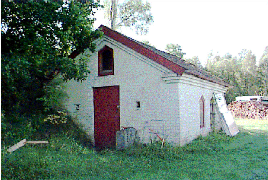
En mindre källarstuga är kulturbistoriskt intressant men också i behov av renovering. Dess röda lertegeltak, vitmålade tegelfasad samt röda fönster och dörrar bör bevaras.
