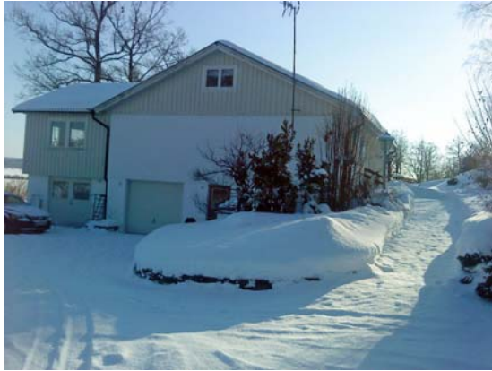
Bild 1-1. Gavelfasad mot nordost på Nävervägens vändplan. Passagen till höger går in till fastighetens baksida
