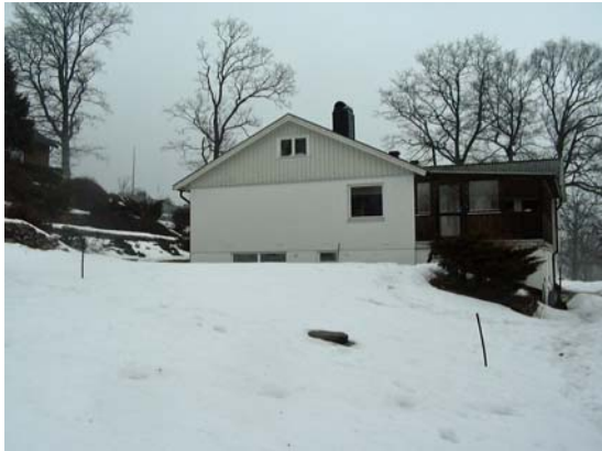
Bild 1:4. Sjöby 3:40 gavelfasad mot sydväst
