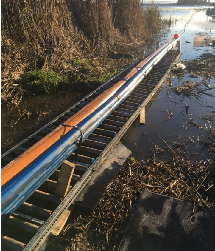
Figur 15. Arbetet med nedläggning av sjöledning. Svetsad ledning dras ut i sjön på ett tillfälligt rullband.
