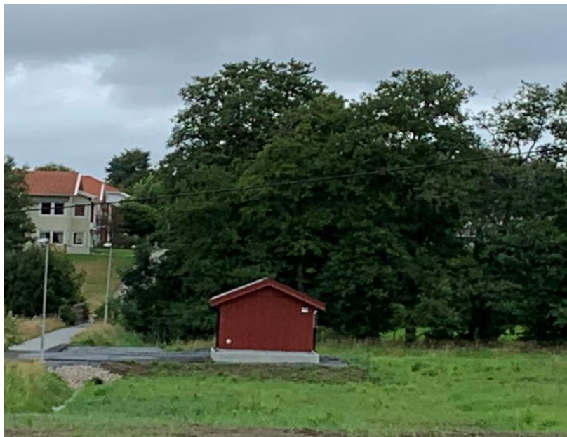
Figur 18. Exempelbild, byggnad för en pumpstation.
