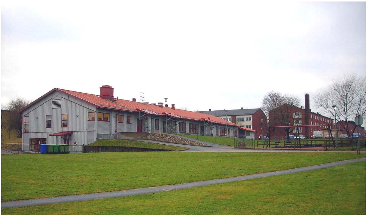
Förskolan sedd från nordost
